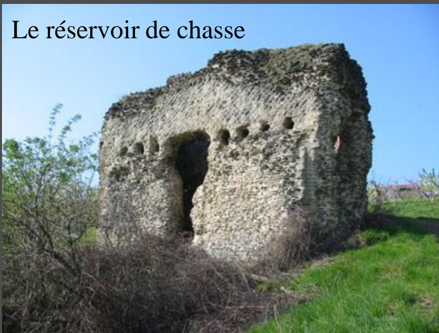
Le réservoir de chasse
