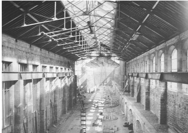
Photographie tirée de l'ouvrage de Denis Varaschin, la construction du canal de Jonage .
