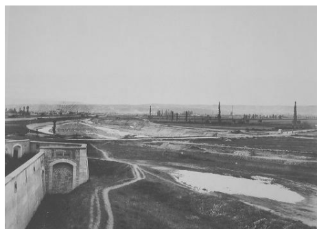
Photographie tirée de l'ouvrage de Denis Varaschin, la construction du canal de Jonage.
