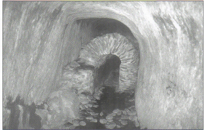
La Cave du Curé, à Chagnon (Loire), est un tunnel creusé pour le passage du canal (photo J. Burdy).
