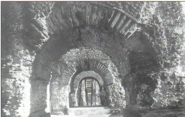
Perspective à travers les piles du pont-siphon de Beaunant (photo J. Burdy).
