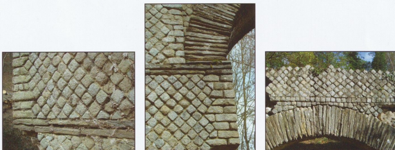
Fig. 3 - Limites et bordures du parement réticulé en granite. Saint-Maurice-sur-Dargoire, pont des Granges et pont de Jurieux.
