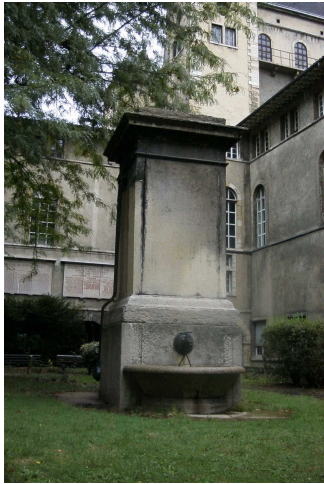
Puits de l'Hôtel Dieu
