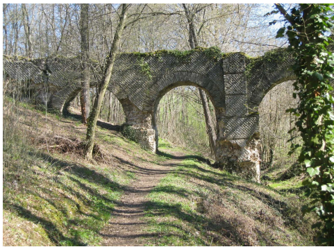
Aqueduc du Gier.
