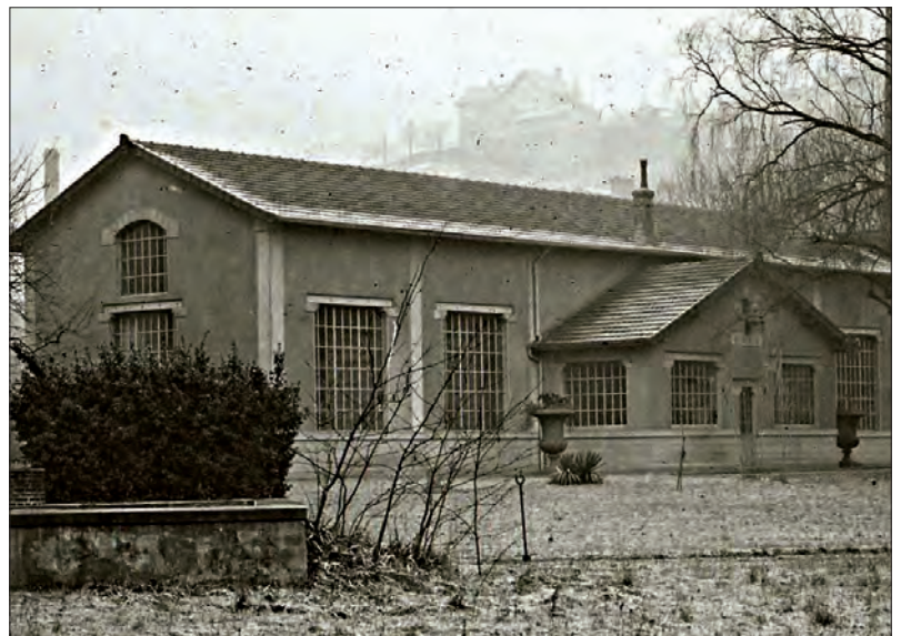
On aperçoit deux vases devant l'usine des pompes électriques, vers 1910
