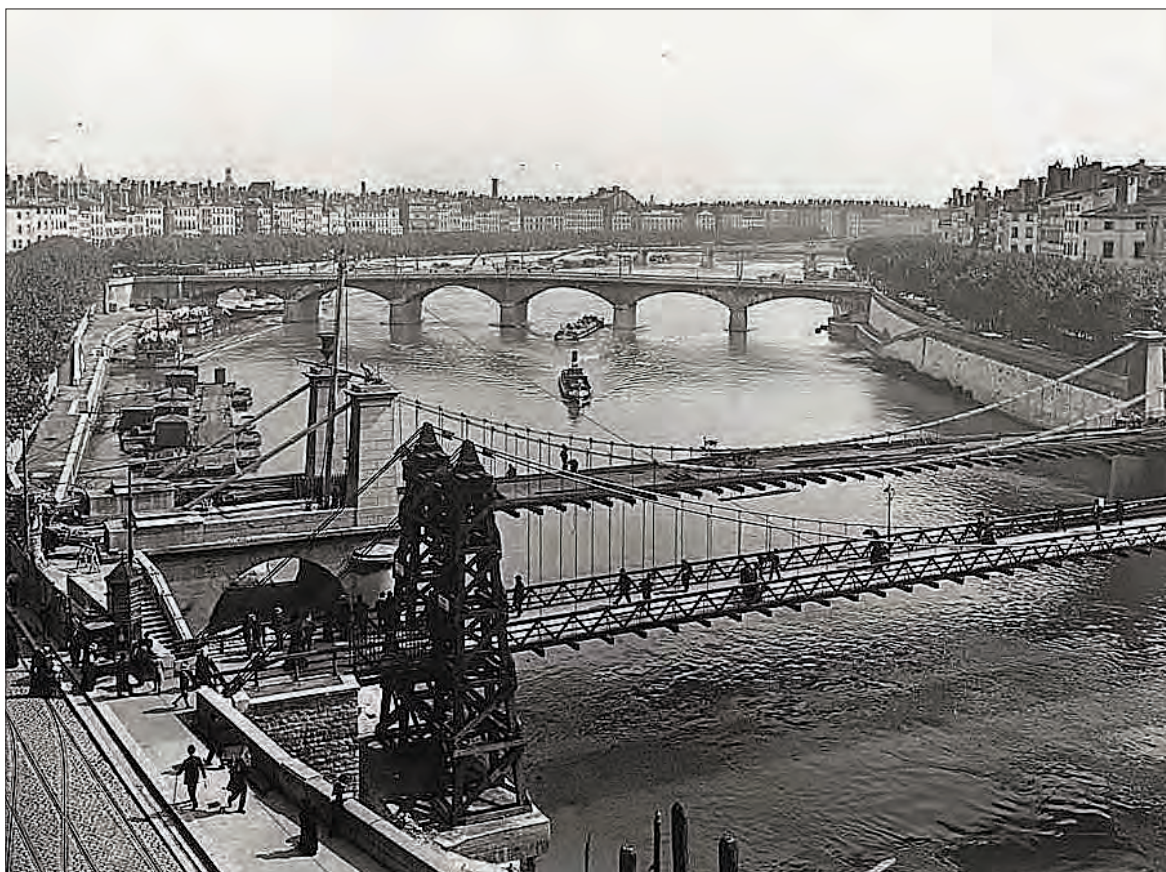
La démolition du pont. Une passerelle provisoire a été installée
