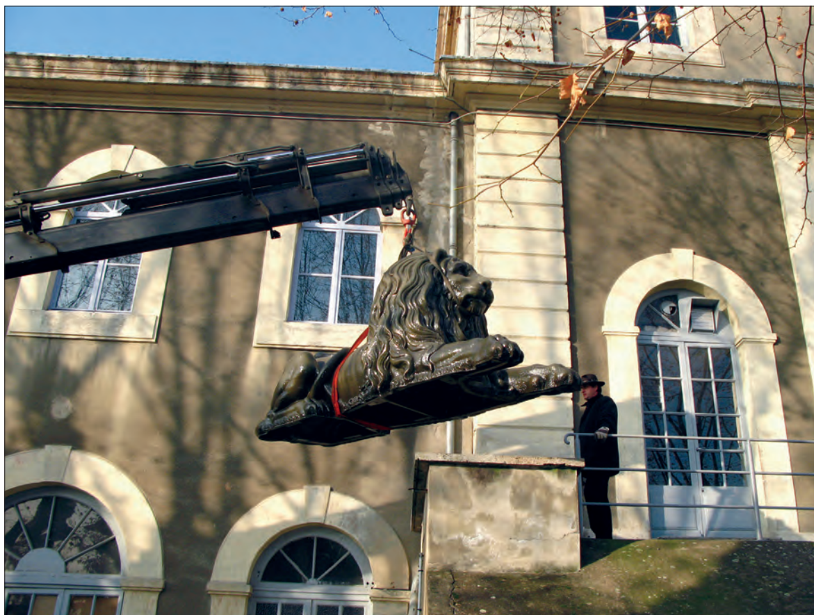
Remise en place après lifting
